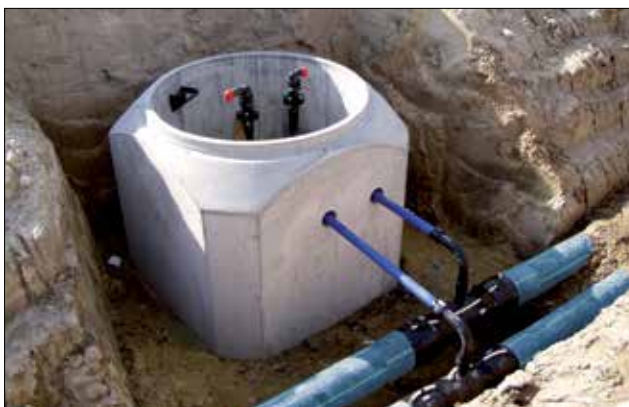
5.78 Anbohrarmaturen zur Schachtanbindung
