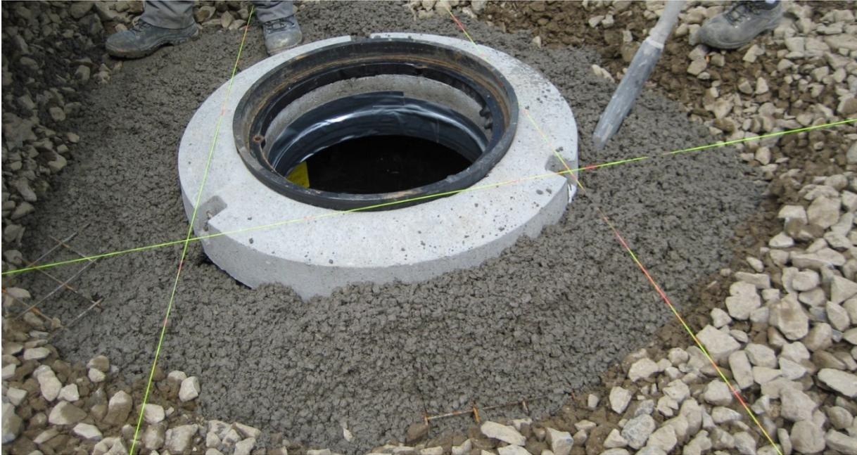
Abbildung 4: Abstützung Betonauflagering
