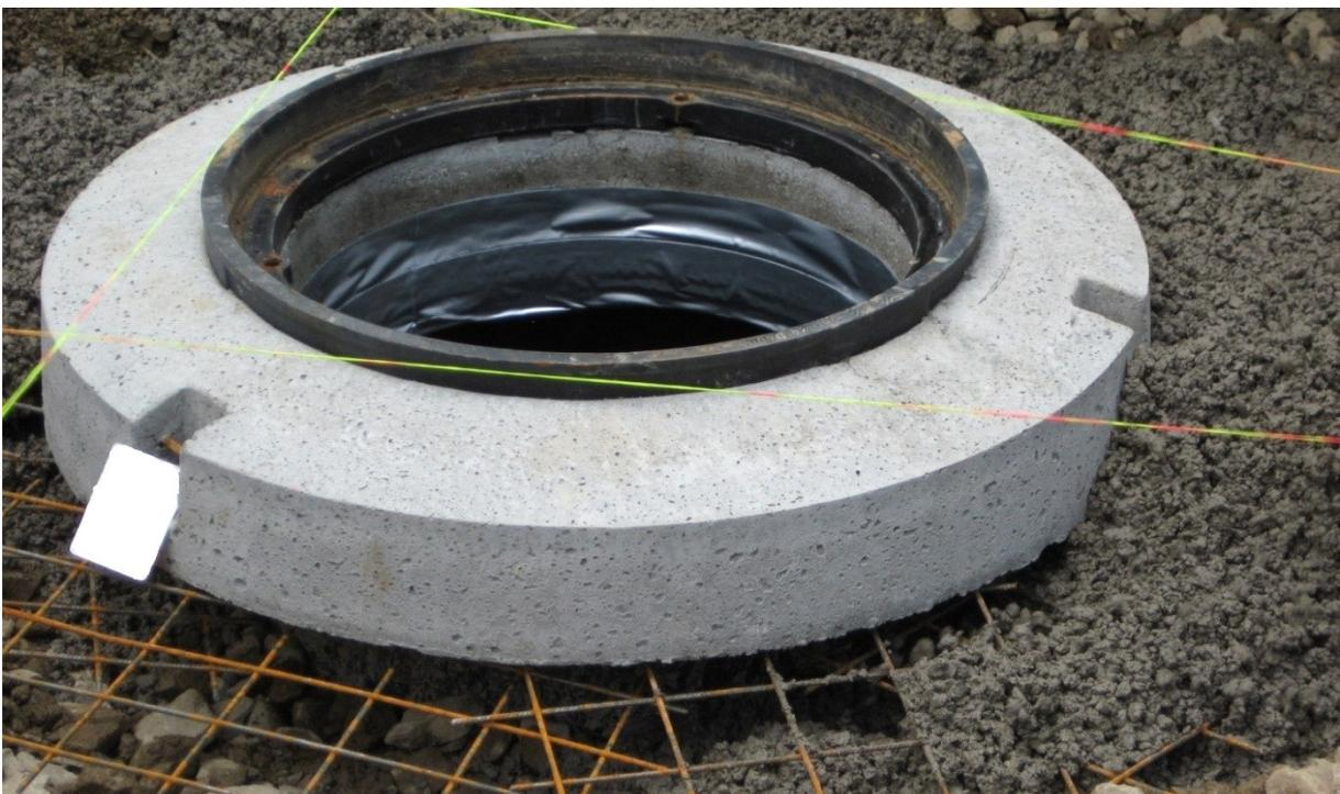
Abbildung 3: Abstützung Betonauflagering
