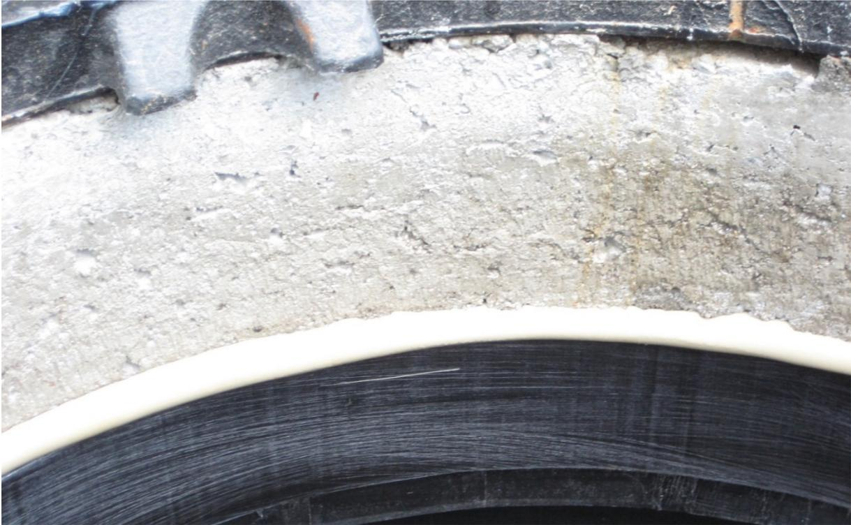
Abbildung 2: Schichtprinzip mit Betonauflagering
