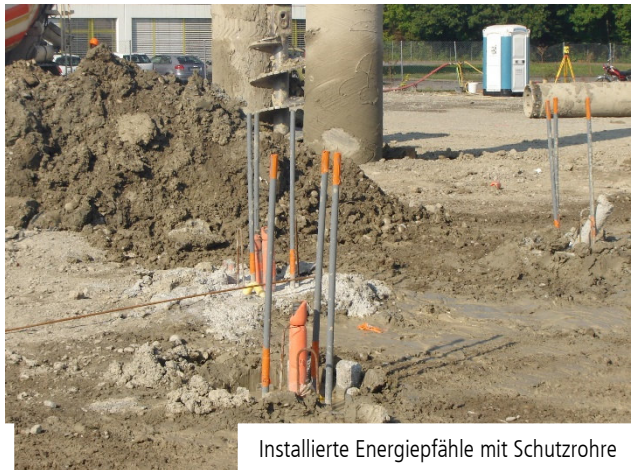
Einfache U-Sonden als Energiepfahl
