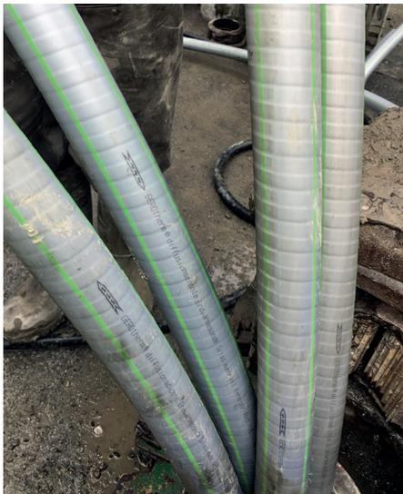
**6** Flussrichtungspfeile sowie beidseitige Metrierung analog zu den Standardsonden vorhanden
