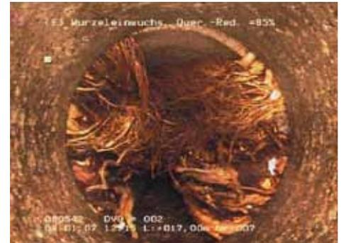
Abb.: Problem alter Kanalnetze: Baumängel – Wurzeleinwuchs bei Steckverbindungen (Bild einer Kamerabefahrung, Quelle: Dipl.-Ing. Ralph Wegener, Ing.-Büro Rinne & Partner)
