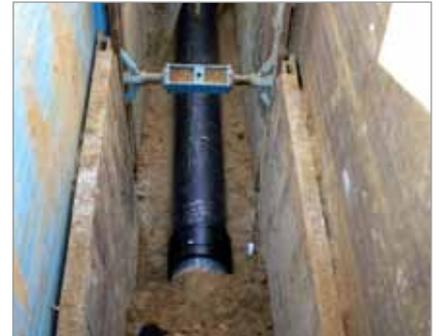
Bild 3: GEROblanco® Kanalrohr, Verlegung im Sandbett
