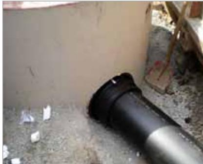
Bild 2: Systemtechnik: Schachtanbindung, Übergang auf andere Werkstoffe möglich
