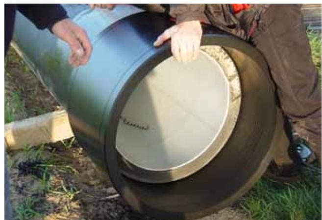
Abb.: Montage Elektroschweißmuffe auf GEROblanco® (Bildquelle: +GF+)
